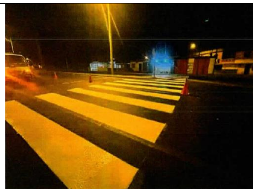
Señal horizontal, zona de semáforo
