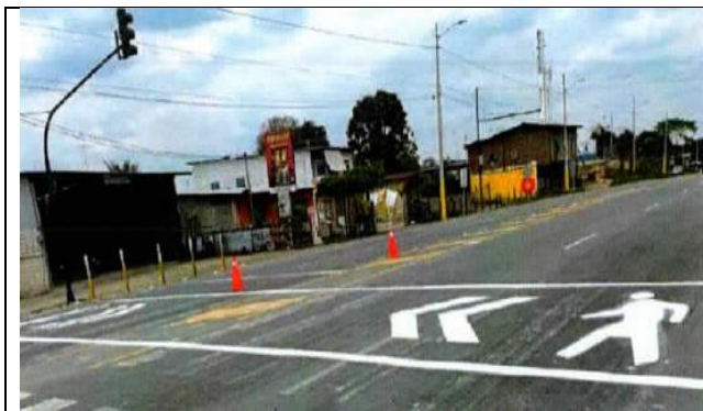
Señal horizontal, zona de semáforo
